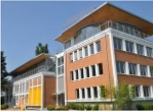
Umbau eines ehemaligen Wasserwerks in den Hauptsitz der SolarWorld Holding AG, in Bonn. Technik: Zentrale Wärmeversorgung über vier Wärmepumpen. Wärmequelle Grundwasser - Einleitung in den Rhein. 600m<sup>2</sup> Photovoltaik. Planung Gewerke: Heizungstechnik, Sanitärtechnik
